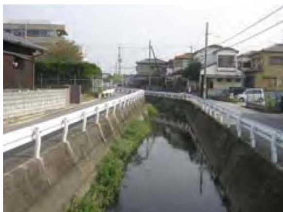
ながす対策例：別府川 5-7 号雨水幹線（開削工法 U 型）
