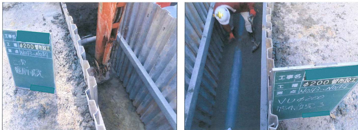
汚水管渠布設工事の状況
