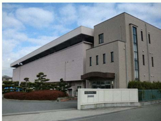
(安田中継ポンプ場)
