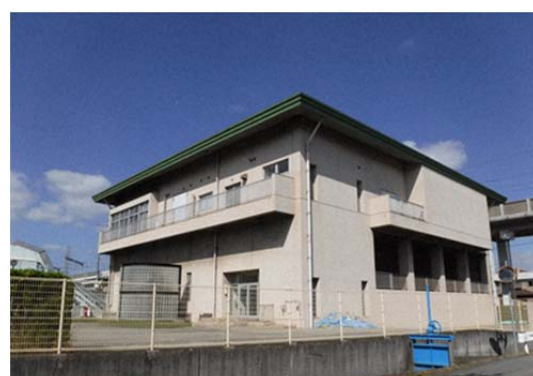
(新野辺雨水ポンプ場)
