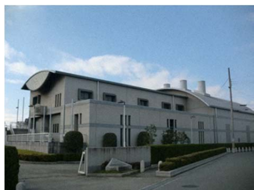
(西脇雨水ポンプ場)
