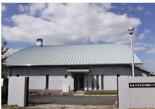
(石守中継ポンプ場)
