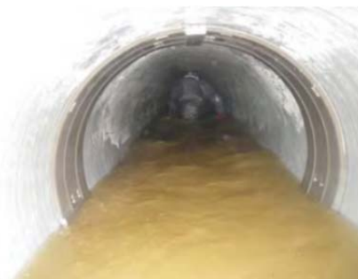
耐震化対策の状況（管渠の継手部の抜出し対策）
