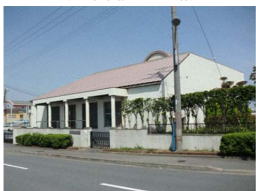
(中島雨水ポンプ場)
