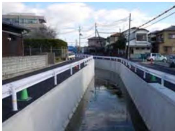
ながす対策例：別府川 5-7 号雨水幹線（開削工法 U 型）
