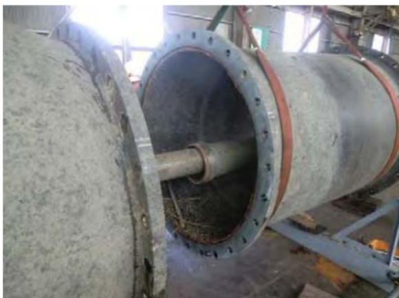
【ポンプを分解中】
