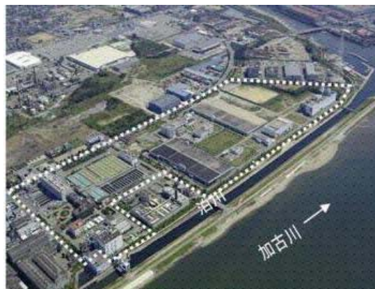
加古川下流浄化センター（全景）
