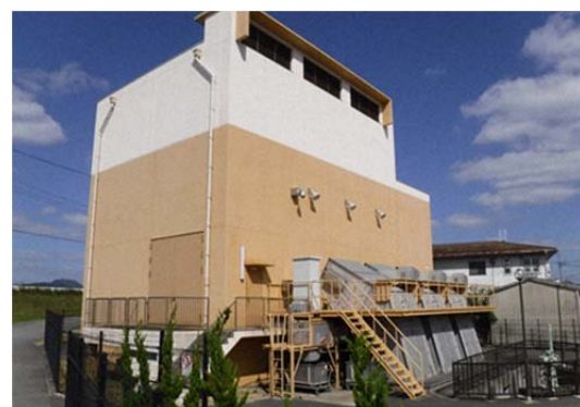
(神野団地雨水ポンプ場)
