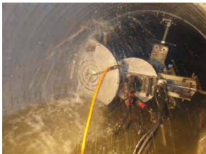
耐震化対策の状況（管渠の継手部の抜出し対策）
