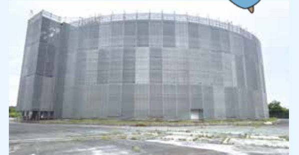
配水池の耐震化更新工事の様子
