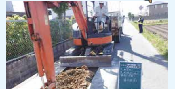
下水道管の工事の様子
