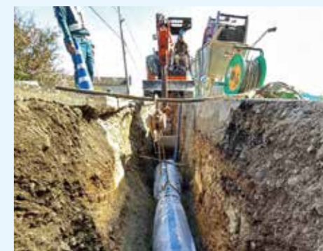
配水管の開削工事の様子
