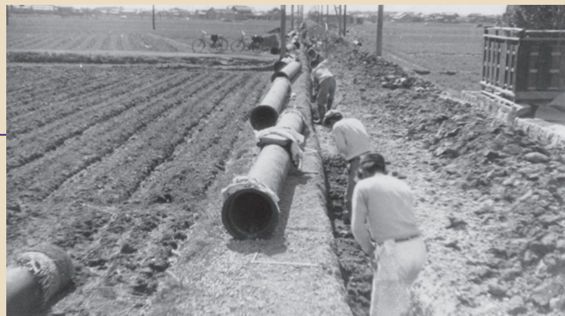
日岡山配水池から市内各所への配水本管を布設している様子
