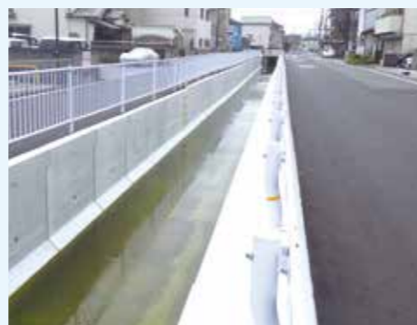
工事が完了した雨水幹線の様子
