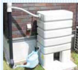
雨水貯留タンク
