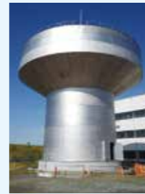
更新した高架水槽(中西条浄水場)
