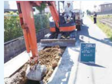
汚水管渠の工事
