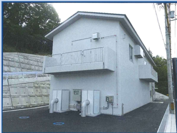
新しいポンプ棟
