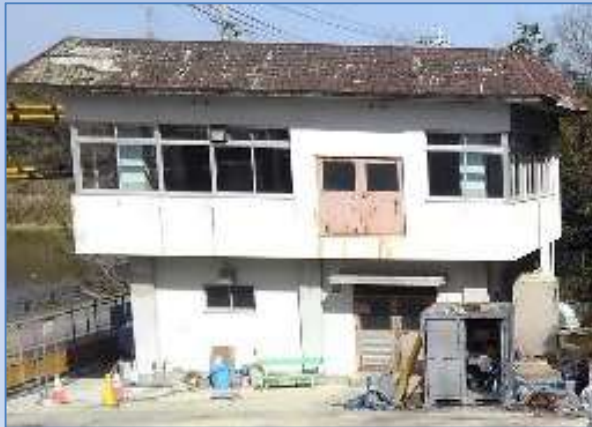
施工前のポンプ棟
