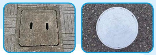
雨水が流れる「 雨水ます 」も。こちらは四角形のものもあります 汚水ますのふたの素材は塩ビや鋳物、コンクリートなどさまざまです
