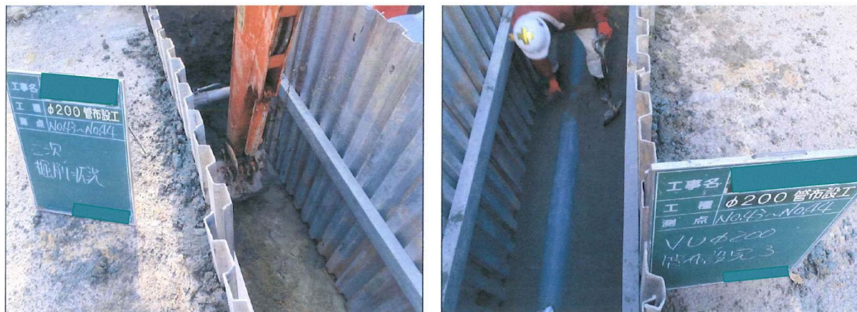
汚水管渠布設工事の状況
