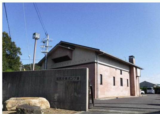
(池尻中継ポンプ場)
