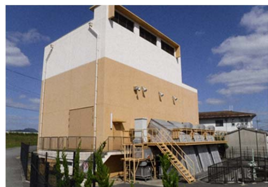
(神野団地雨水ポンプ場)
