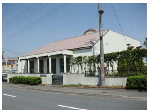
(中島雨水ポンプ場)
