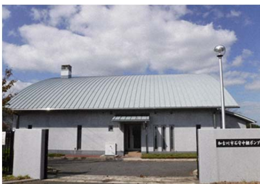
(石守中継ポンプ場)
