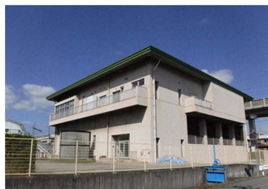
(新野辺雨水ポンプ場)
