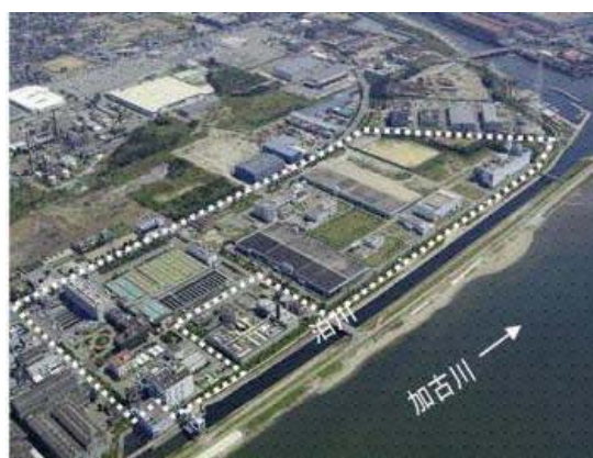
加古川下流浄化センター（全景）
