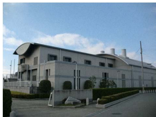
(西脇雨水ポンプ場)
