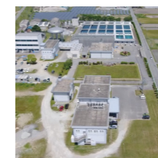
中西条浄水場
