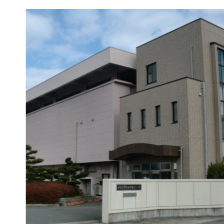
安田中継ポンプ場
