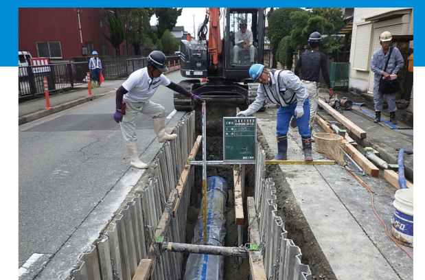
水道管布設替工事
