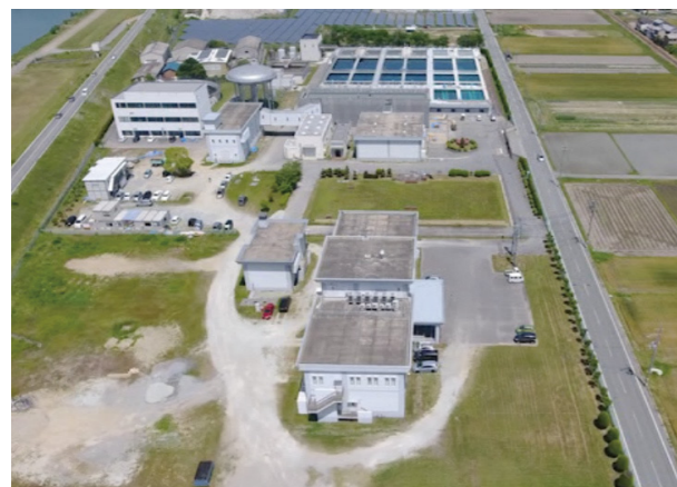
中西条浄水場
