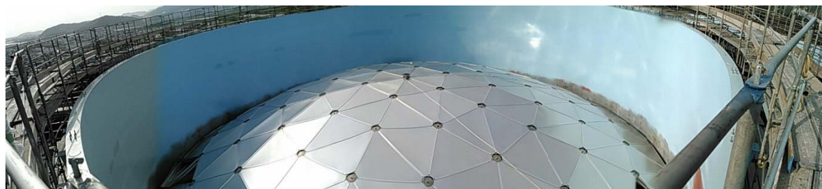
アルミドーム屋根組立状況
