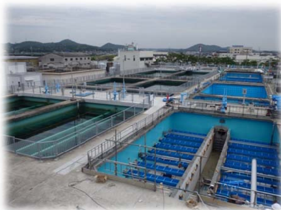
中西条浄水場浄水処理施設
