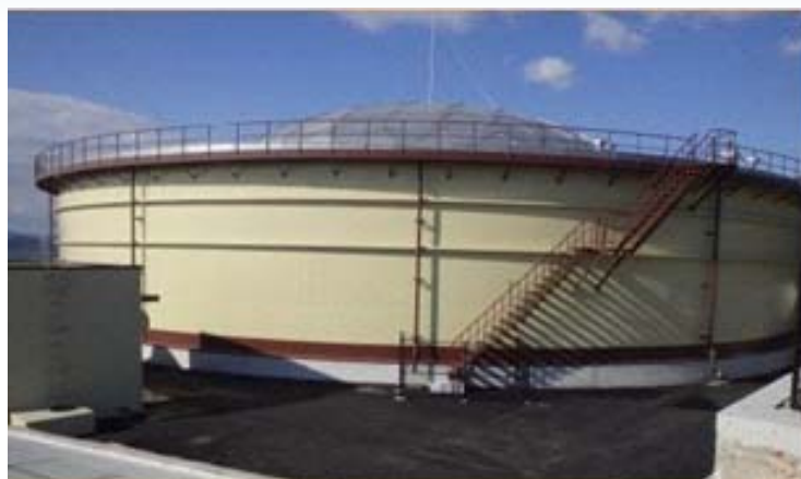
完成した新しい城山配水池
