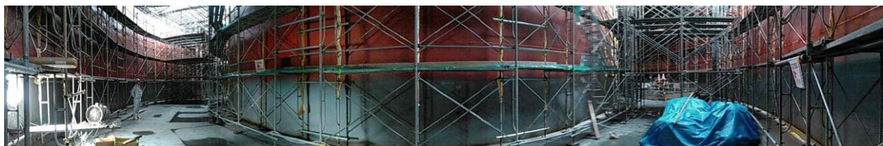
配水槽組立状況（外槽）
