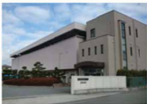
(安田中継ポンプ場)
