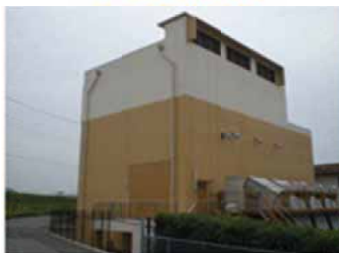
(神野団地雨水ポンプ場)
