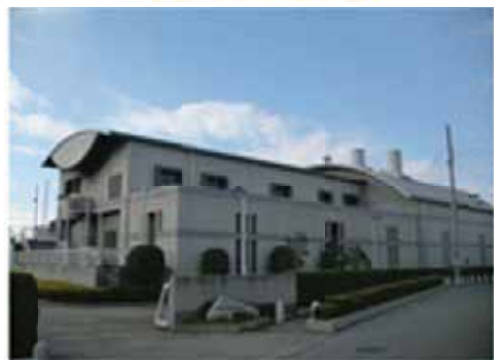
(西脇雨水ポンプ場)
