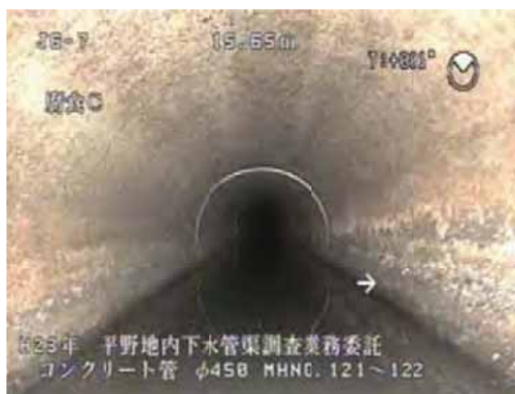
管渠のカメラ調査
