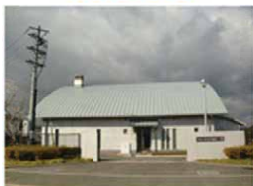
(石守中継ポンプ場)
