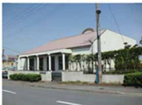
(中島雨水ポンプ場)
