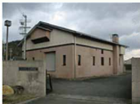
(池尻中継ポンプ場)
