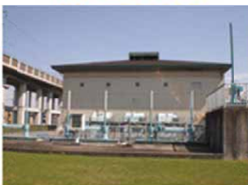
(新野辺雨水ポンプ場)
