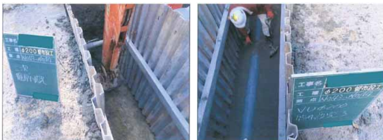
汚水管渠布設工事の状況
