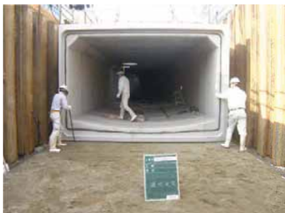
ためる対策例：合流区域※の浸水被害軽減（加古川分区貯留槽）
