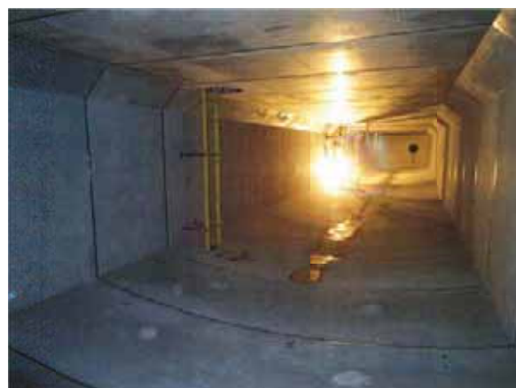
ためる対策例：合流区域※の浸水被害軽減（加古川分区貯留槽）
