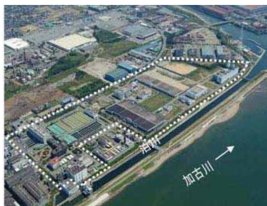
加古川下流浄化センター（全景）
