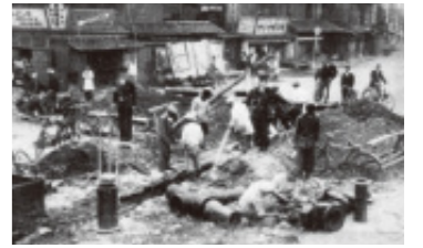
加古川町における配水管布設工事
