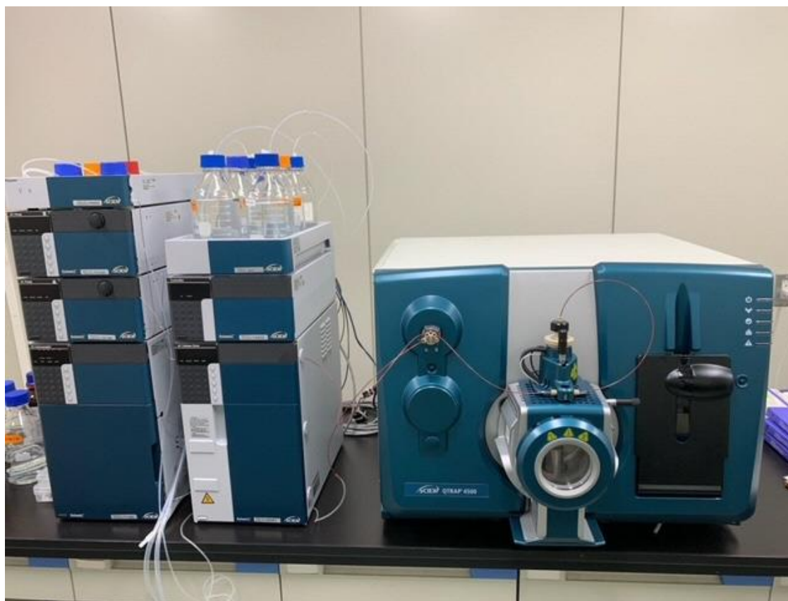
中西条浄水場 水質試験室 令和3年度に更新した液体クロマトグラフ質量分析装置（LC-MS-MS）
