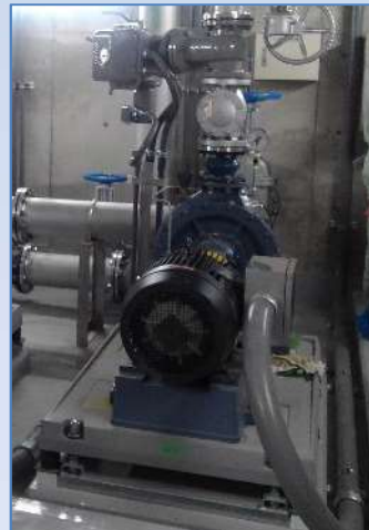
機械設備工事
