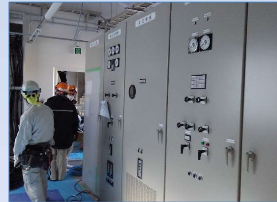
電気設備工事
