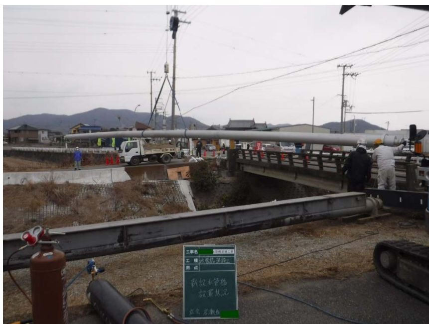
(水管橋更新工事)
