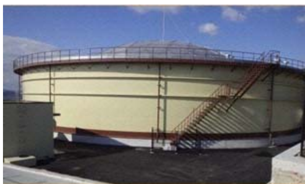
完成した新しい城山配水池
