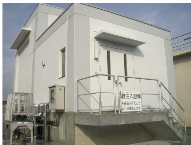
中西条浄水場 酸注入設備
