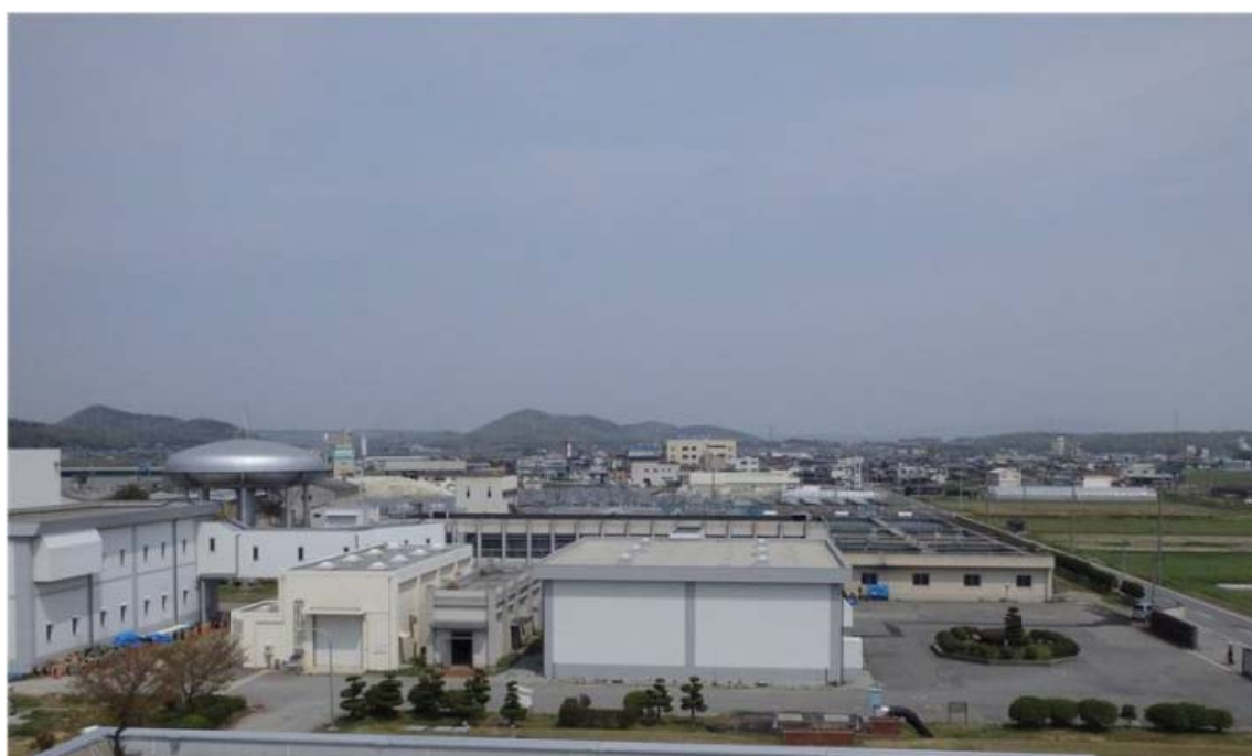
(中西条浄水場)
