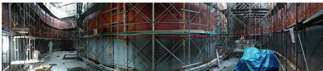
城山配水池更新工事
