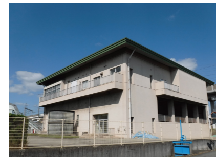
新野辺雨水ポンプ場
